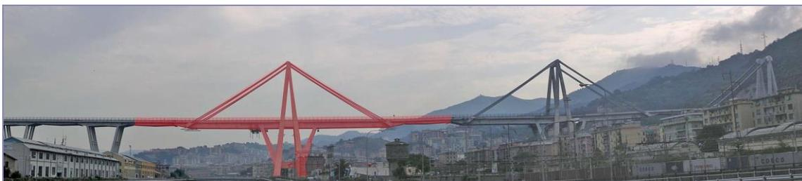
Fig. 6 - In rosso la parte crollata del ponte.
